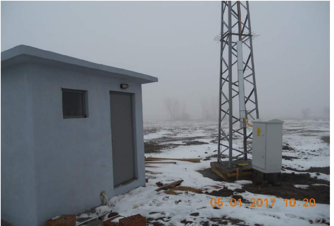
7. Kırklareli İli Pehlivanköy İlçesi Doğanca Köyü İçme Suyu Yeni Sondaj Bağlantısı Yapılması İşİ Resimleri.
