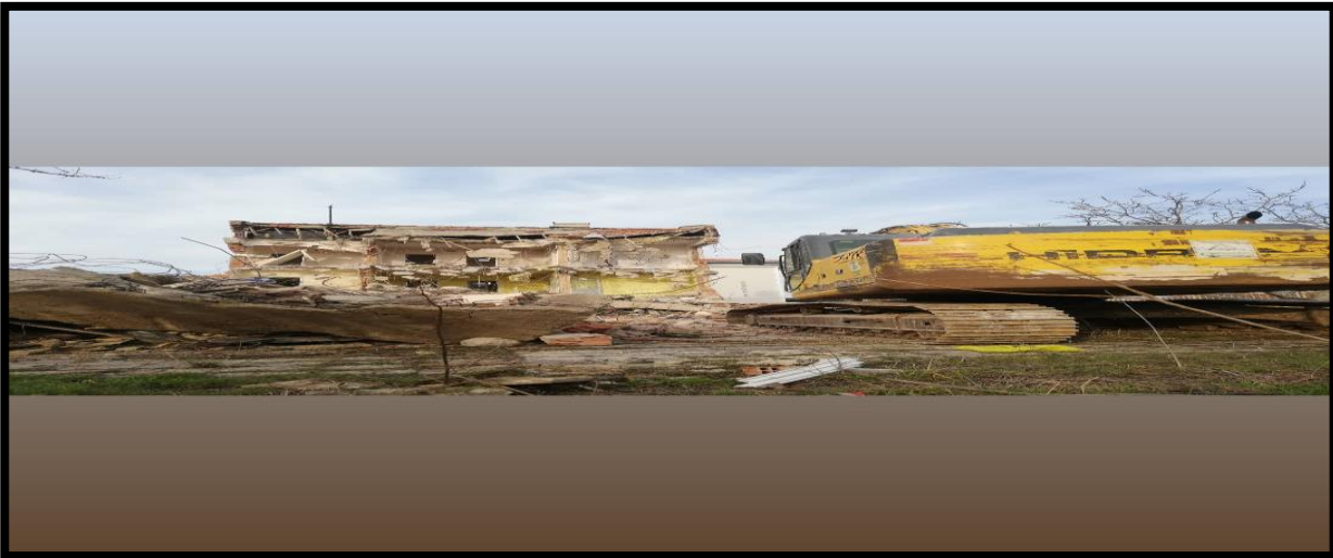
Vize TSM+Lojman Binası Yıkım Fotoğraf
