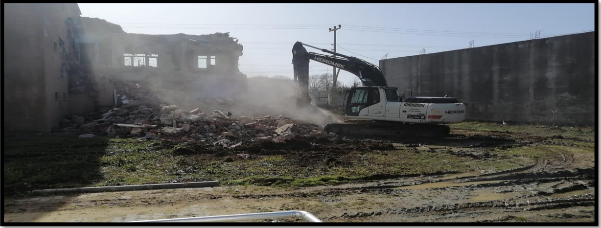
Kıyıköy Lojman Binası Yıkım Fotoğraf
