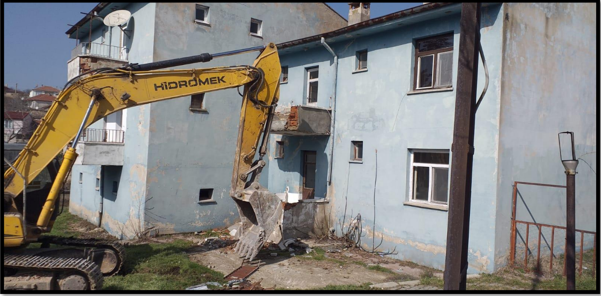
Üsküp Sağlık Lojman Binası Yıkım Fotoğraf
