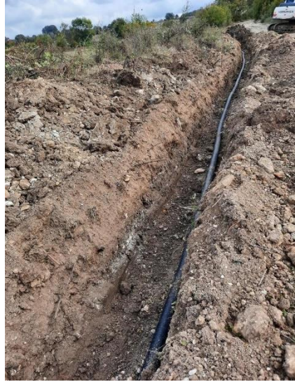
İsale Hattı Yapım Çalışması
