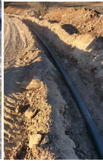
Boru Döşeme Hattı
