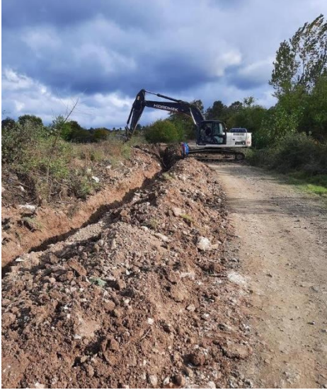
İsale Hattı Yapım Çalışması
