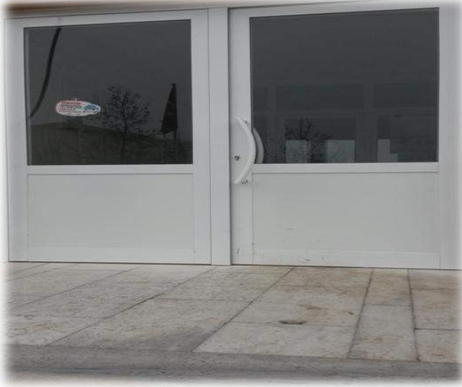
Sağlık Müdürlüğü Hizmet Binasına Alüminyum Doğrama kapı yapılması
