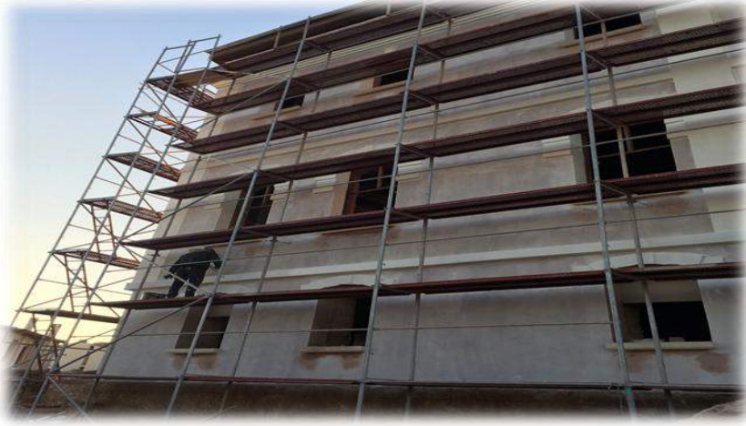
Kırklareli Vali Faik Üstün İlköğretim Okulu Restorasyon Yapımı İşi Projesi
