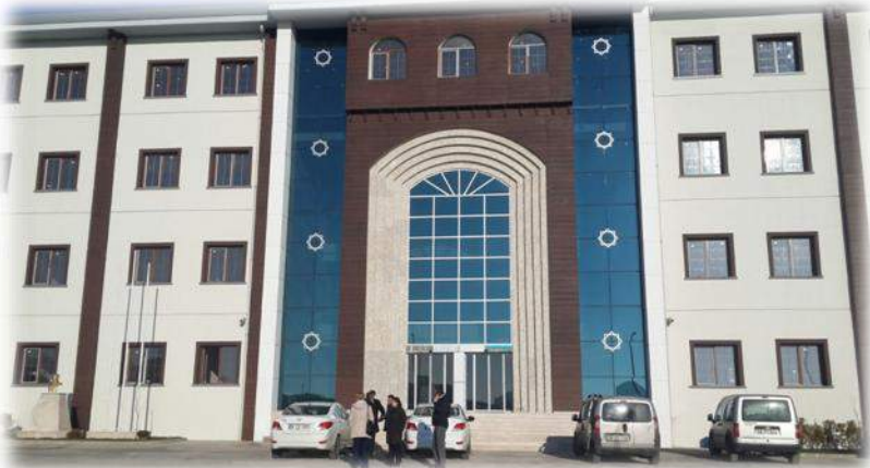
Kırklareli İli Lüleburgaz İlçesi Hükümet Konağı Yapım İşi Projesi
