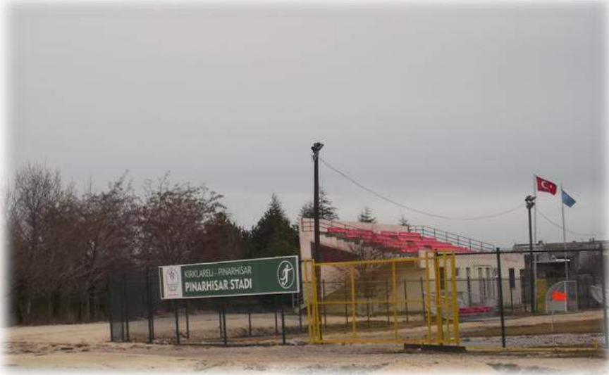
Pınarhisar İlçesine çim saha çevre tel örgü yapılması
